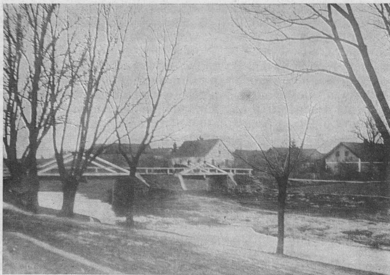
Eymenisbrücke in Warnen
