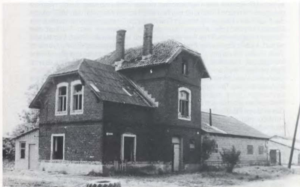
Bahnhofsgebäude der Kleinbahn in Kraupischken 1990
