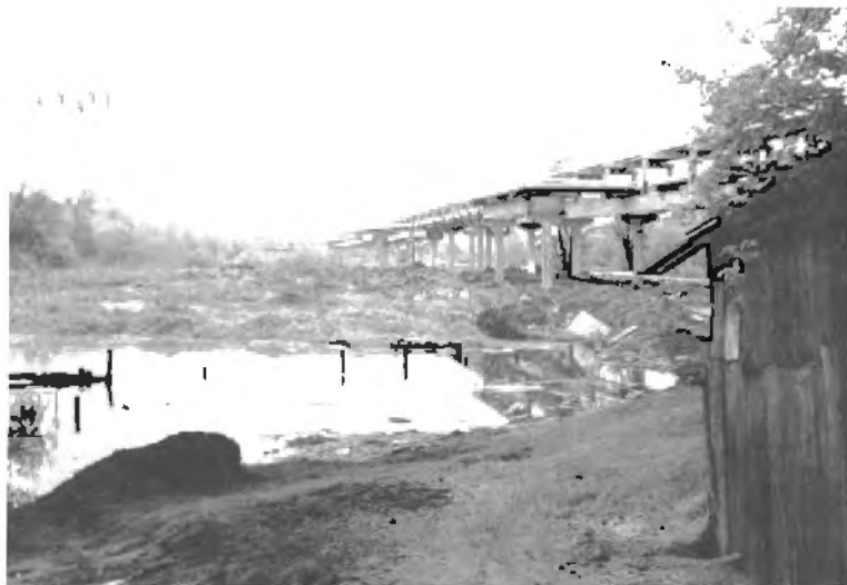
Kloake mit Fernwärmeleitung
