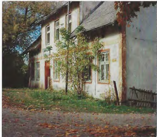
Gesamtansicht des Waldmannschen Hauses 1994. Rechts an der Frontseite vermutlich die Reste des alten Gartenzaunes
