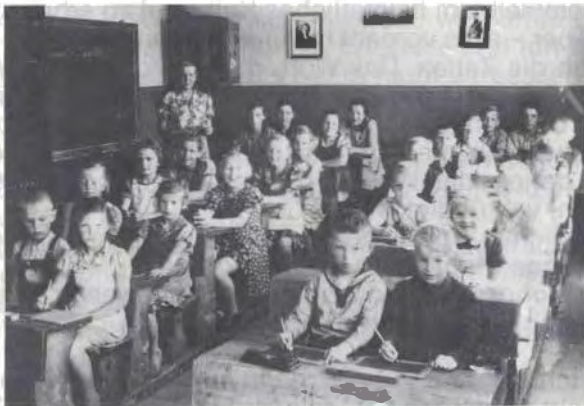
Einklassige Schule in Kallenfeld 1941 (fr. Groß Pillkallen) bei Breitenstein
