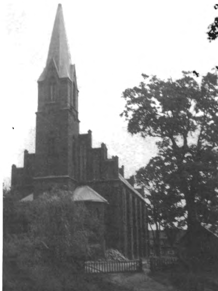
Die Kirche in Lasdehnen wird renoviert
