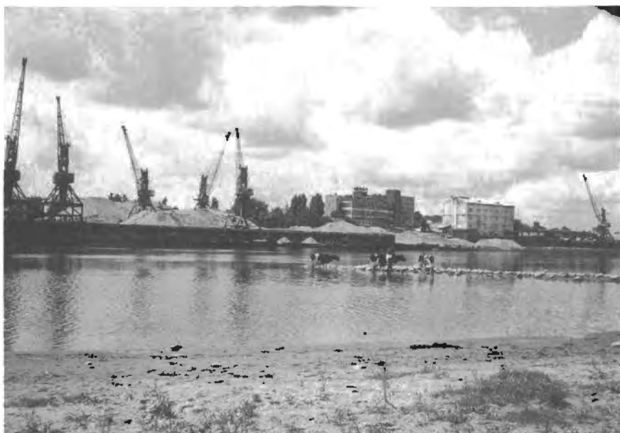
Blick von Übermemel nach Tilsit, Es zeigt drüben die Umgebung des früheren Hafenspeichers auf der Memelstraße.
