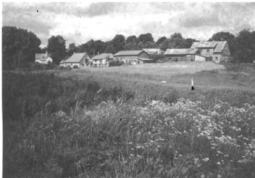
Blick von der neuen Straßenbrücke über die Piktupe auf Piktupönen.
